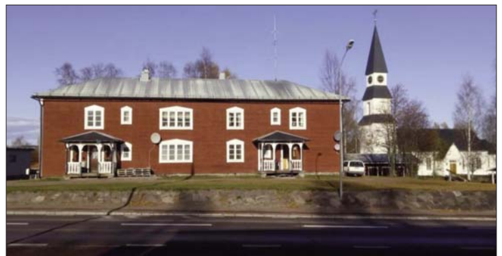
MAGNEHILL Affärsfastigheten förstördes i en brand 1938. En del av byggnaden kunde repareras och heter nu "Magnehill". Bild: Visit Särna
