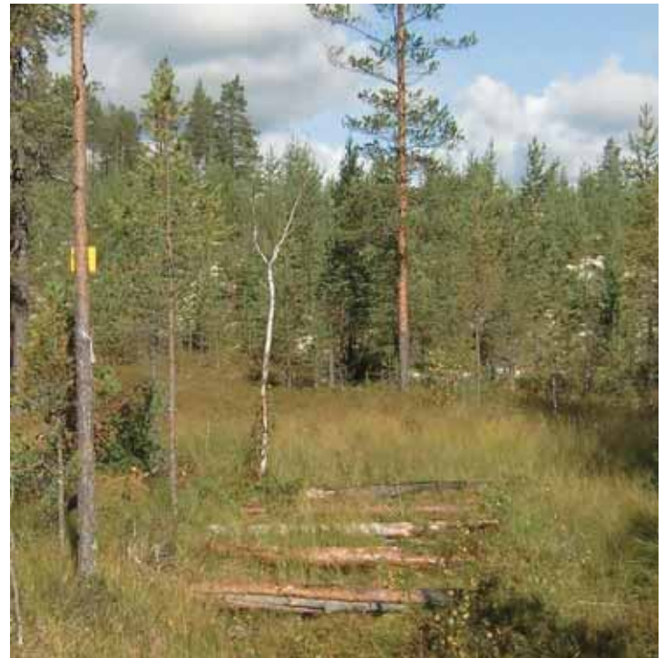
Nybyggd klappbro över blötmyr. Foto H.Forslund
