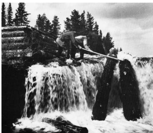
Ibland räckte det inte att man byggt styrkanter i älvar och forsar. Då fick man ge sig ut på det "hala". Som här vid Fjätfallen (Särna). Det var inte så många av flottarna som var simkunniga. Så det var riskfyllt jobb och klämskador var inte ovanliga och drunkningsolyckor hände.
